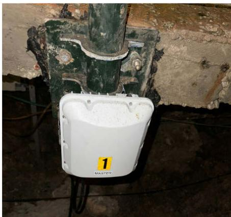
Figura 11. Router inalámbrico instalado debajo del sendero de cemento dentro de la cueva. (Foto O. Gabai)
